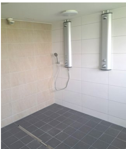
Blick in die neue Dusche
